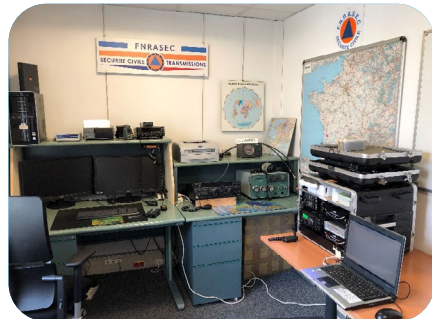
La station F6PCT au ministère de l'Intérieur à Beauvais.
